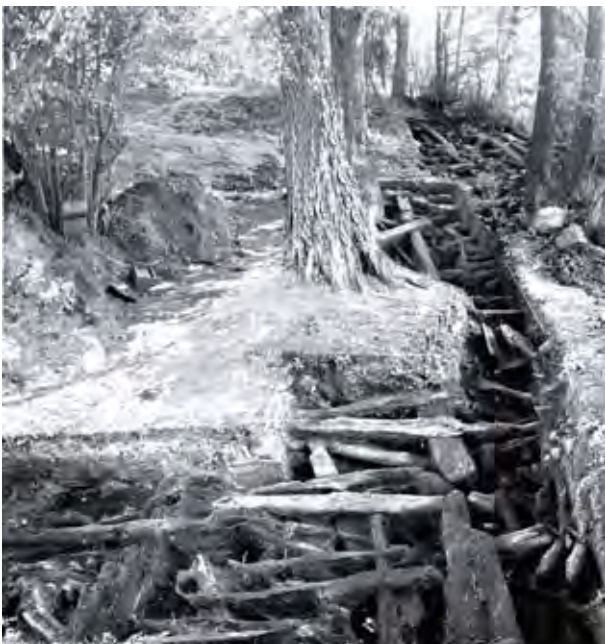
Abb. 13. Ostrów Lednicki – Vorburg. Konstruktionen der westlichen Uferbefestigung (Foto W. Kujawa).
