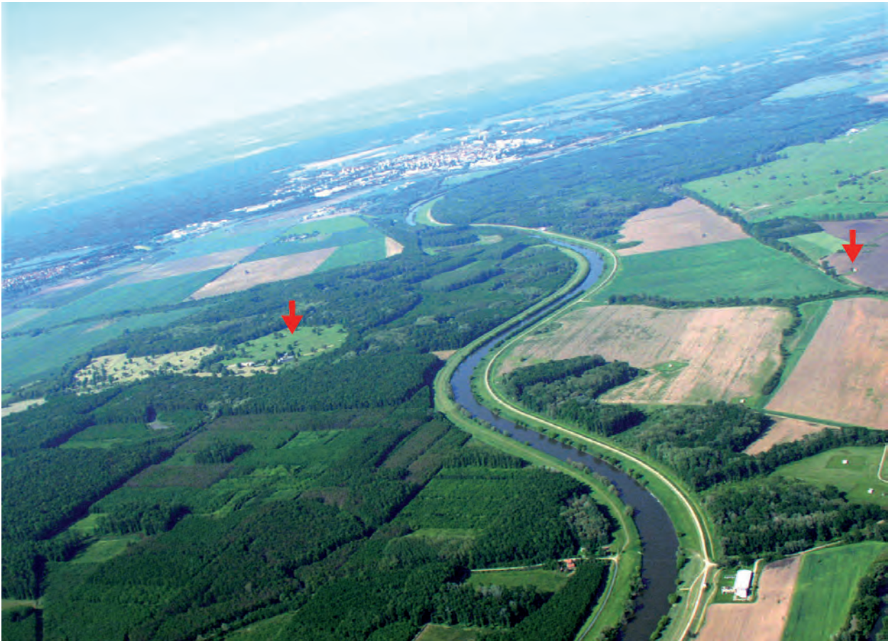
Taf. 15. Die Gesamtsituation des Siedlungskomplexes von Mikulčice-Kopčany mit heutigem kanalisiertem Flusslauf der March. Links: Burgwall „Valy“ bei Mikulčice, rechts: St. Margarethen-Kirche bei Kopčany. Foto P. Baxa.
