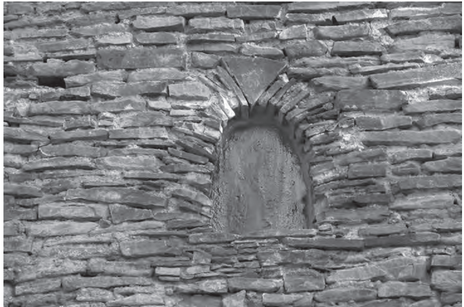
Abb. 4. Kopčany, Kirche St. Margarethen. Nordwand, Detailsicht des Fensters. Foto M. Frouz.
